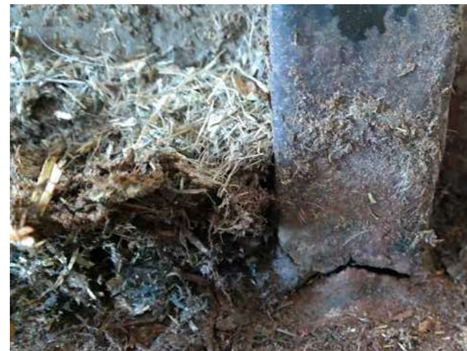
Stolpe ved udvendigt foderbord.
